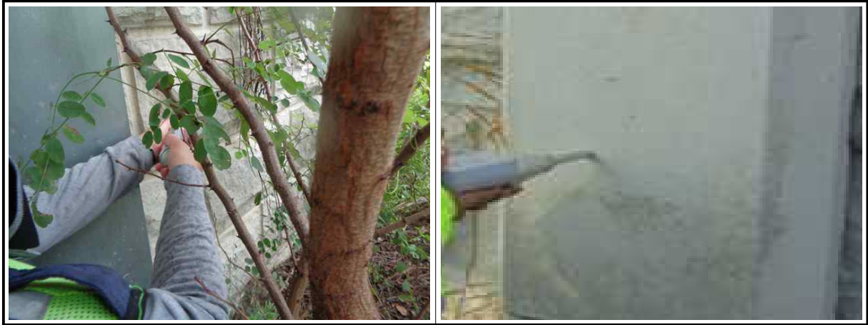
【그림 7.3.6】 슈미트해머를 이용한 반발경도시험 전경
